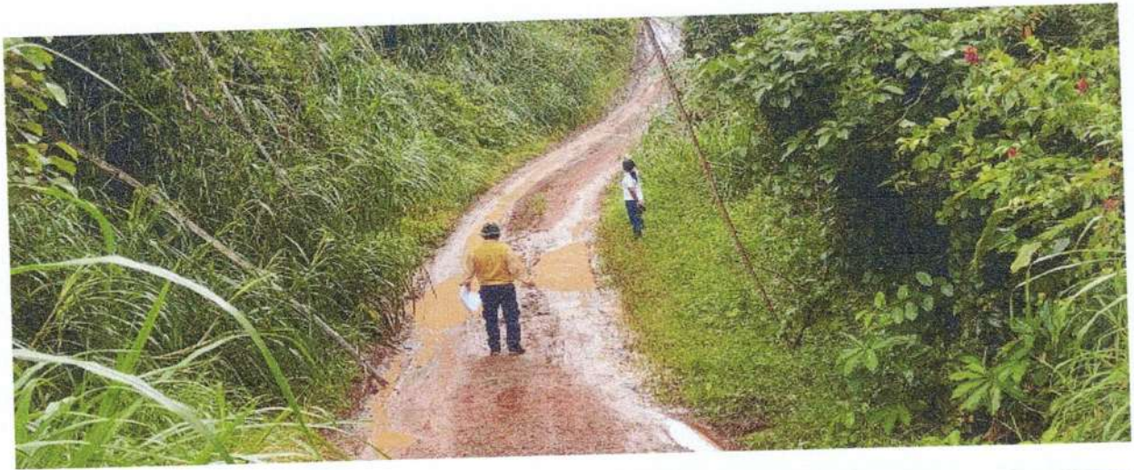
ภาพถ่ายสำรวจถนนลงหินคลุก หมู่ 2 บ้านดอกจำปี ตำบลเขาค้อ อำเภอเขาค้อ จังหวัดเพชรบูรณ์ ถนนสายเข้าไร่ นายสมชาย วันทา จุดที่ 1 ก่อนดำเนินการ
