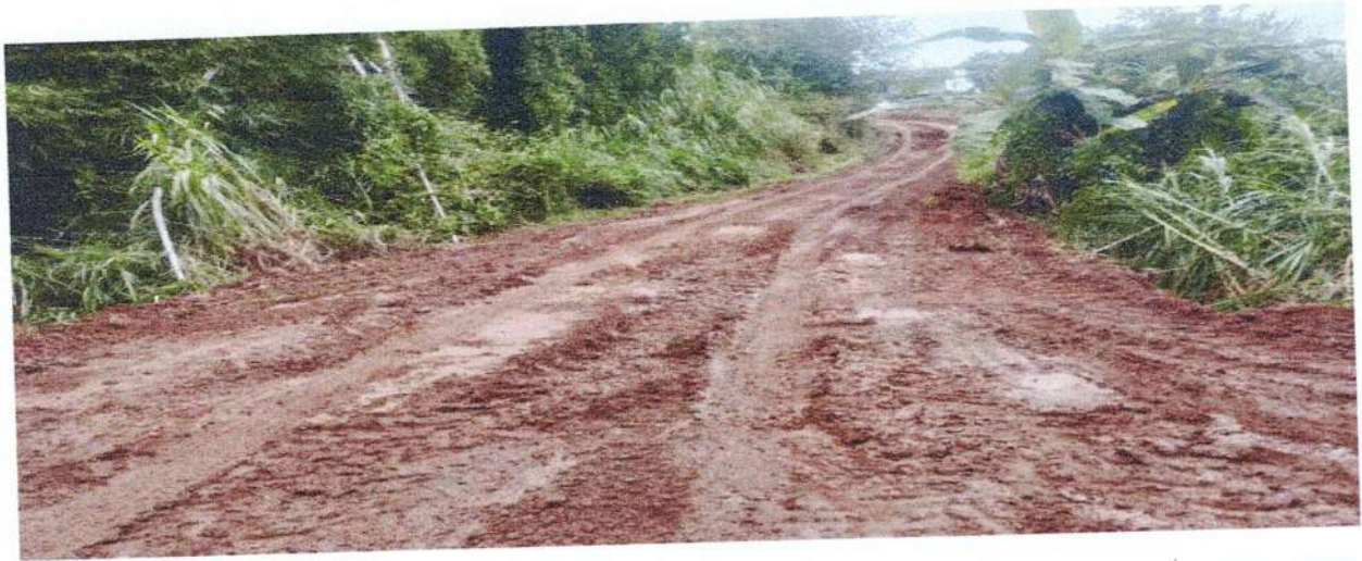
ภาพถ่ายสำรวจถนนลงหินคลุก หมู่ 2 บ้านดอกจำปี ตำบลเขาค้อ อำเภอเขาค้อ จังหวัดเพชรบูรณ์ ถนนสายเข้าไร่ นายสมชาย วันทา จุดที่ 1 ระหว่างดำเนินการ
