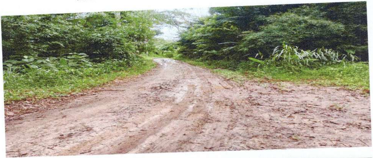
ภาพถ่ายสำรวจถนนลงหินคลุก หมู่ 2 บ้านดอกจำปี ตำบลเขาค้อ อำเภอเขาค้อ จังหวัดเพชรบูรณ์ ถนนสายเข้าแปลงเกษตรสายสปันเวย์ จุดที่ 6 ก่อนดำเนินการ
