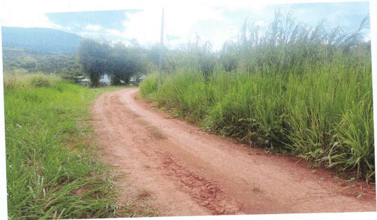
ภาพถ่ายสำรวจถนนลงหินคลุก หมู่ 1 บ้านเขาย่า ตำบลสะเดาะพง อำเภอเขาค้อ จังหวัดเพชรบูรณ์ ถนนเส้นทางเข้าไร่แปลงเกษตร จุดที่ 3 ก่อนดำเนินการ
